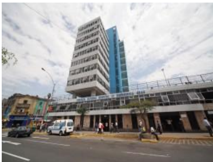
Figura3. Edificio centro de consulta externa hospital Grau
