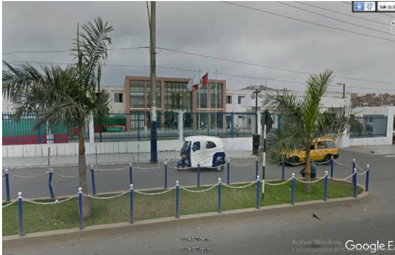
Figura 38: Fachada del INR Fuente: Google Earth
