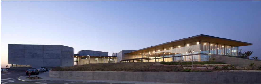
Figura 26: Texturas del Centro de Rehabilitación Beit Halojem Fuente: http://www.kimmel.co.il/
