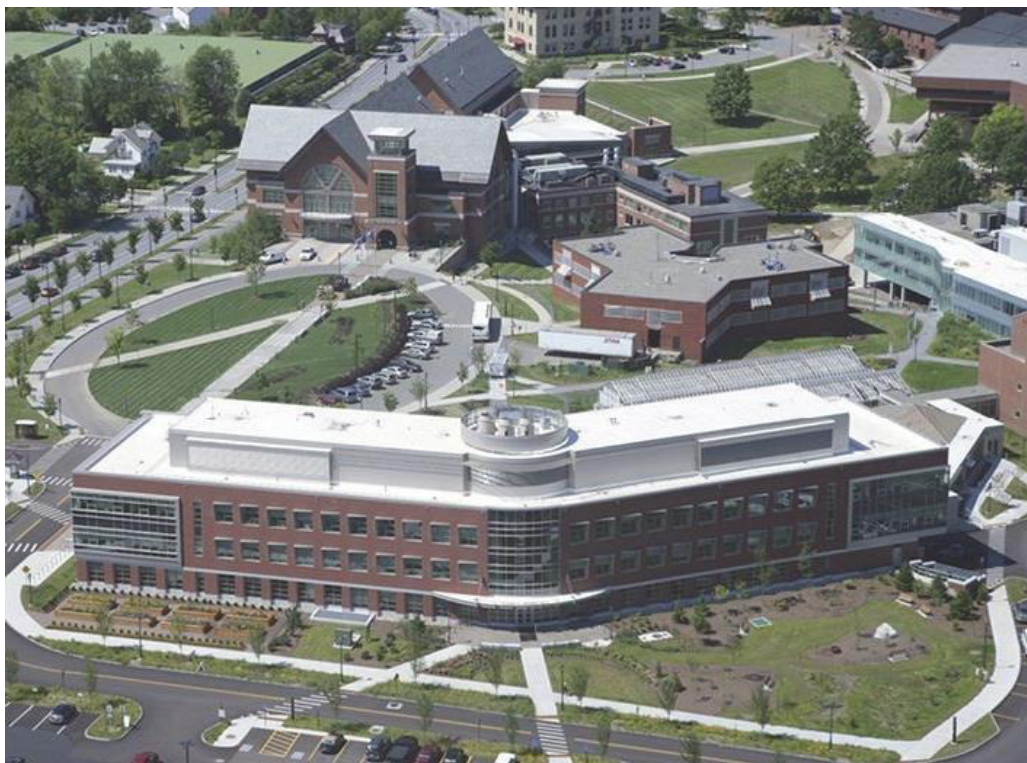
Figura 14. Edificio James M. Jeffords hall Fuente: https://www.flickr.com/photos/afagen/8613484264
