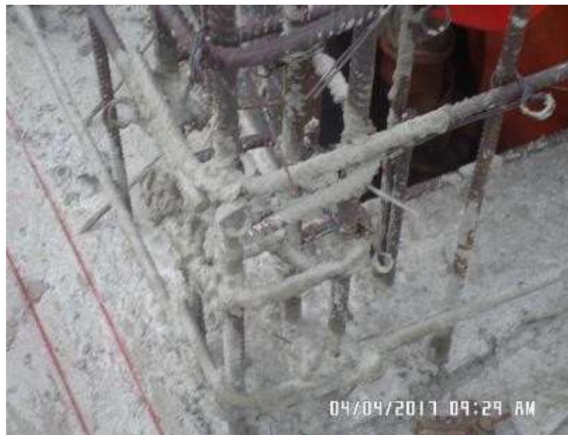
**Foto N° 10** Se encontro acero cubierta de cemento, lo cual le quita la adherencia, se procedió a limpiar para encofrar.
