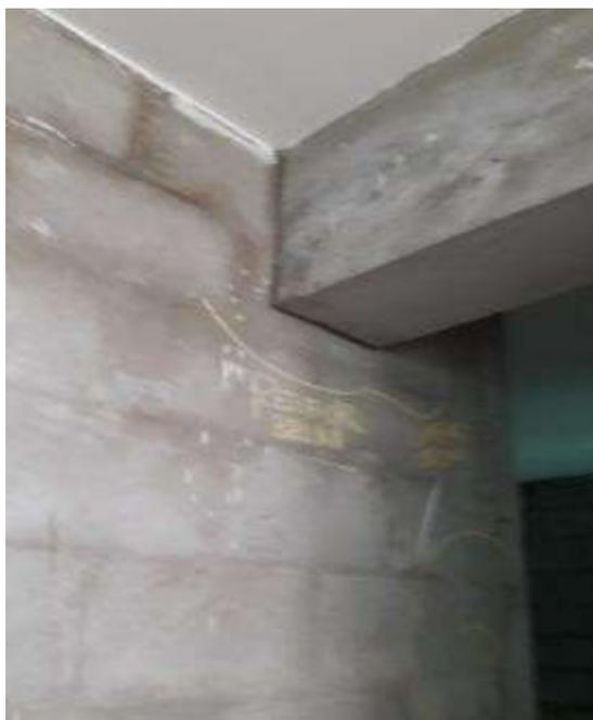
**Foto N° 7** Supervisión no aprobó el gruñado, se identificó a tiempo antes del ingreso de pintura.
