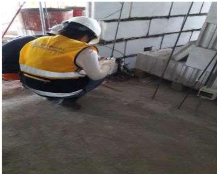
**Foto N° 6** Supervisión revisa los trazos para el ingreso de la cuadrilla de albañilería.
