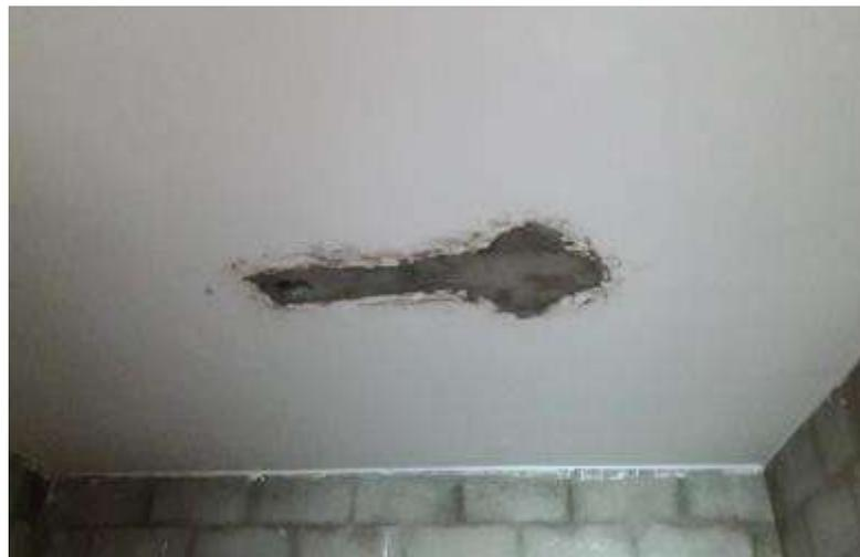
**Foto N° 2** Se identificó un punto fuera de lugar, esto retraso el avance de la pintura de cielorraso.
