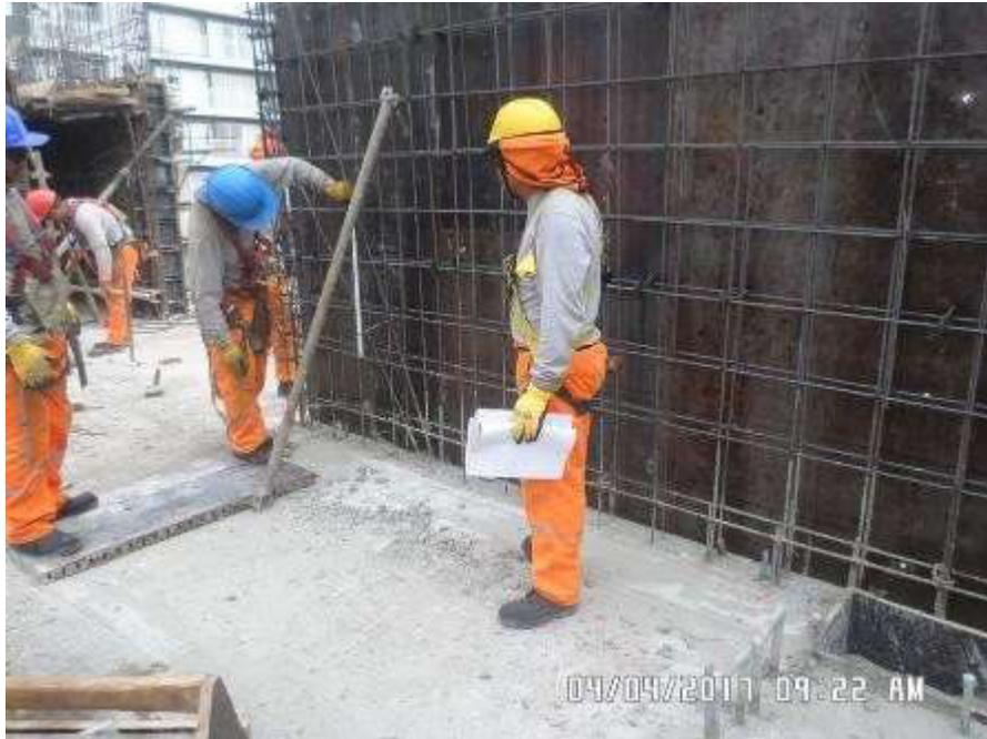
**Foto N° 19** Se verifica la distribución de los aceros de la malla antes de cerrar el encofrado.
