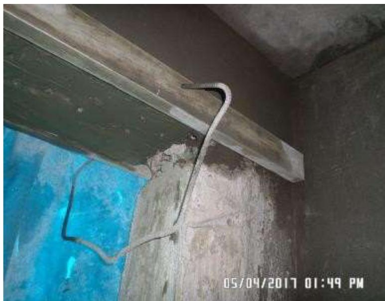
**Foto N° 17** Se encontró cangrejas en la unión de la viga y columna, se comunicó a subcontrata que no se puede tarrajear sin antes resanar. Se paró el tarrajeo.
