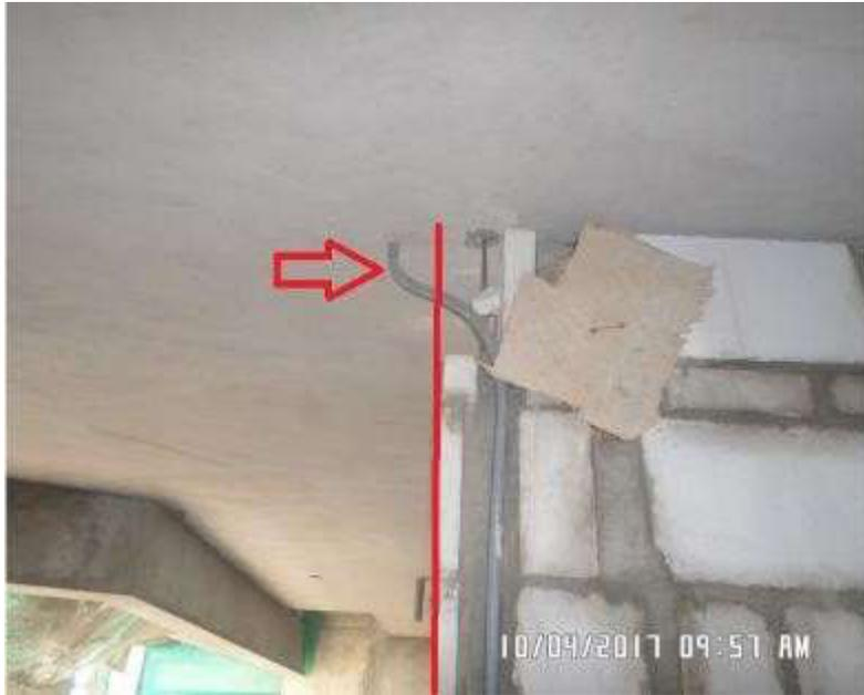
**Foto N° 22** Se puede ver que la tubería se encuentra fuera del muro.
