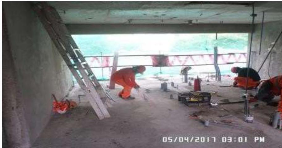
**Foto N° 14** Se detectó el inicio de los trazos para albañilería sin tener el área liberada por parte de instalaciones eléctricas.
