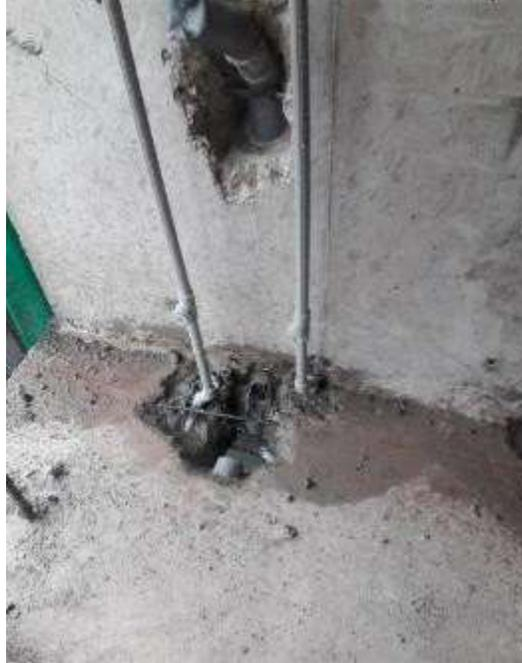
**Foto N° 13** se detectó filtración en la prueba de estanqueidad, se procedió a la reparación.
