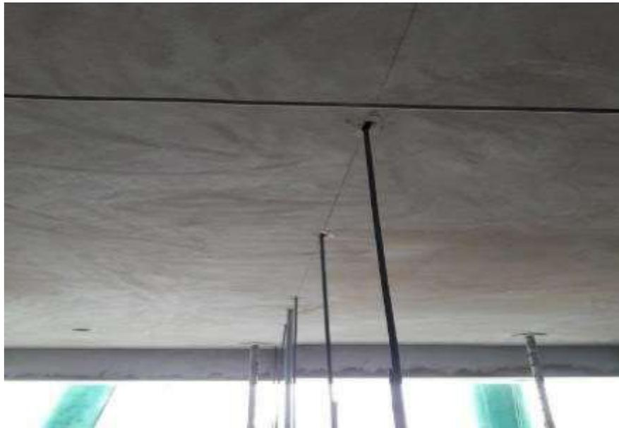
**Foto N° 20** Se anclo correctamente los aceros de albañilería.
