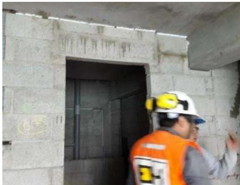
**Foto N° 4** Se identificó que el dintel de la puerta presentaba una inclinación, esto pudo afectar al colocar los marcos.
