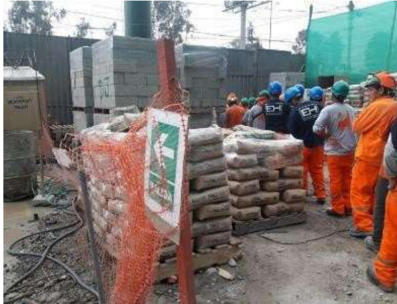
**Foto N° 3** Se mantiene los materiales fuera del contacto del piso, el cuidado de los materiales también afecta a la calidad.
