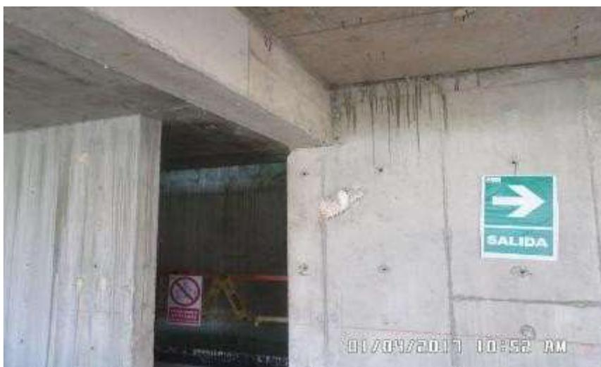
**Foto N° 8** Se encontró tecnopor dentro de la placa, se procedió a retirar y resanar con aditivo.
