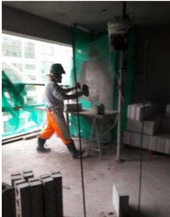
**Foto N° 12** El corte de los ladrillos se realizó en un lugar ventilado y con la protección correcta.
