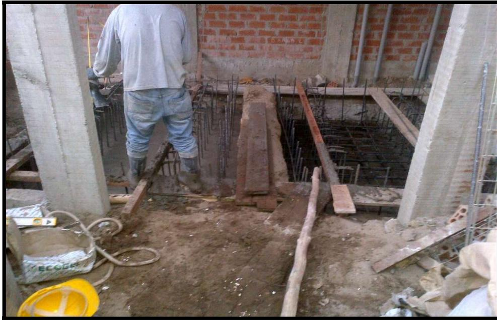
**Foto 21:** Vaciado de posa de derrames en sala de generadores
