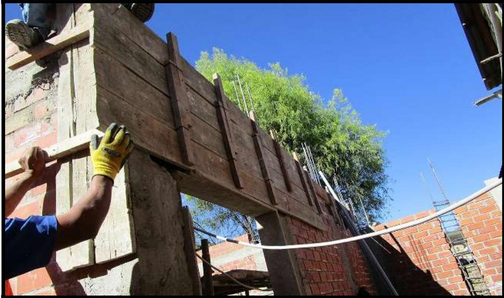
**Foto 9:** Encofrado de viga solera en sala de equipos
