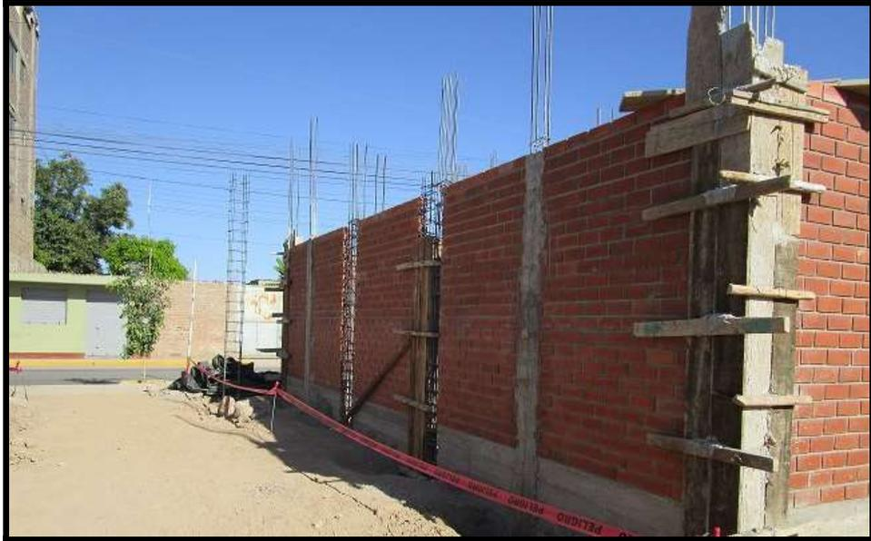
**Foto 17:** Asentado de ladrillo en sala de equipos
