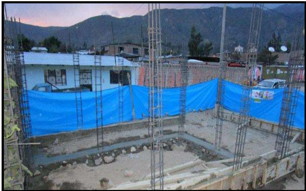
**Foto 4:** Vaciado de sobre cimentación en sala de equipos
