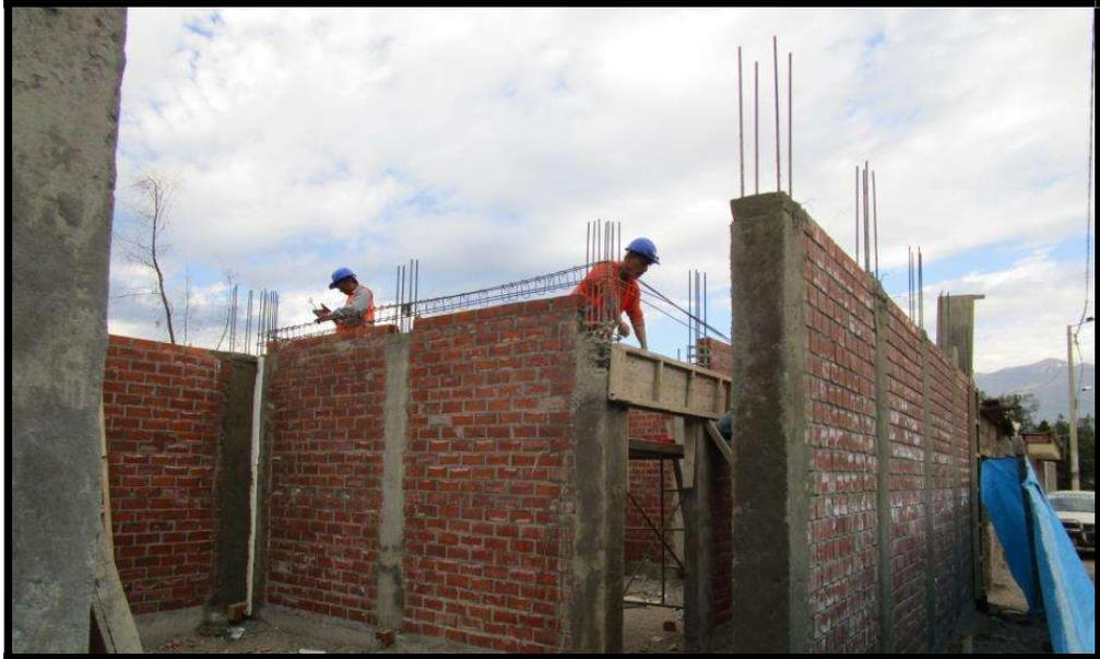
**Foto 7:** Armado de viga collarín en sala de equipos
