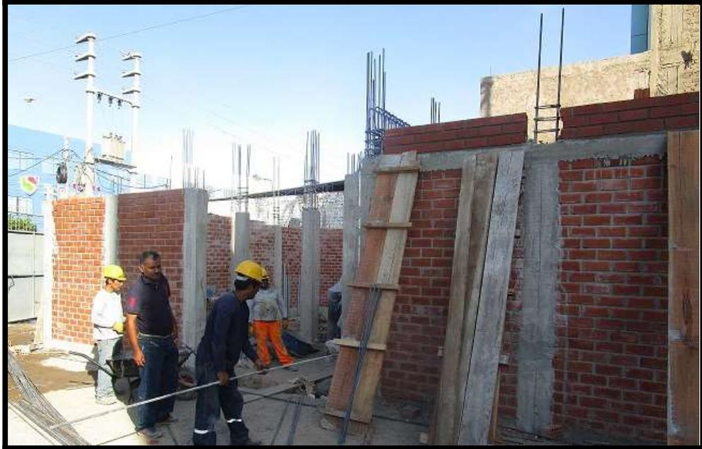
**Foto 19:** Armado de viga collarín en cerco perimétrico
