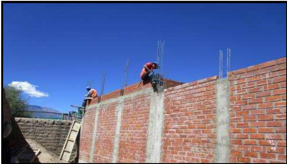
**Foto 8:** Asentado de ladrillo sobre viga collarín en sala de equipos
