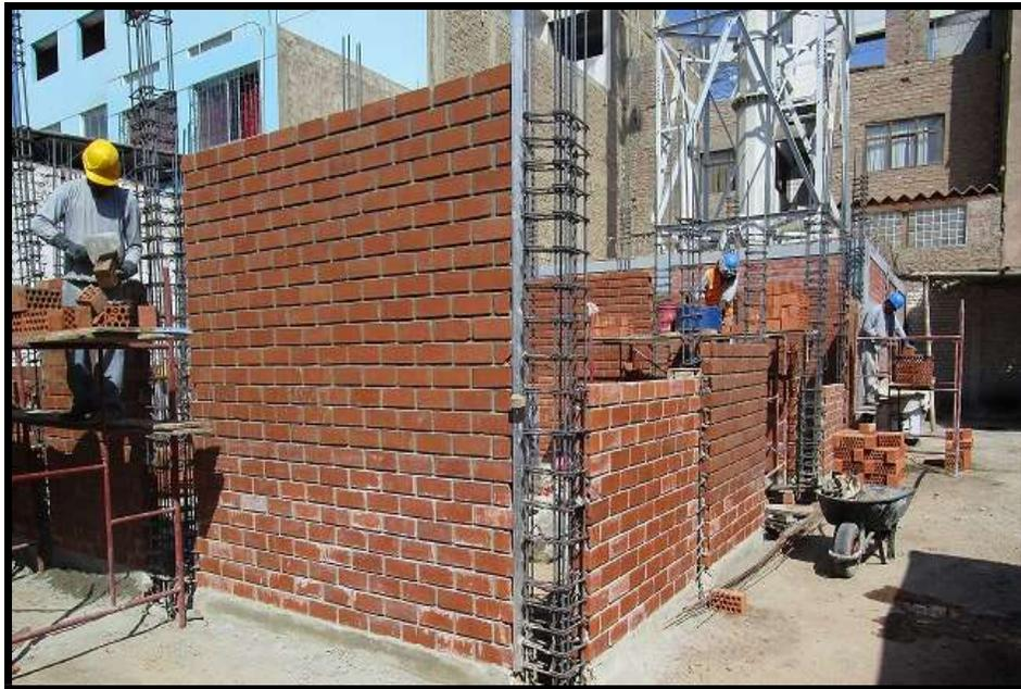
**Foto 18:** Asentado de ladrillo en sala de generadores
