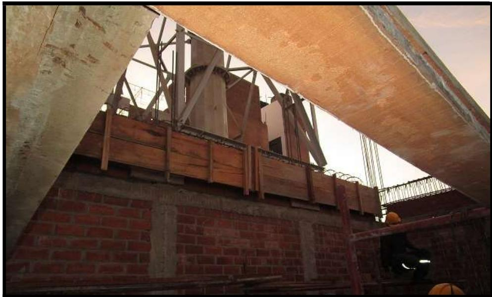
**Foto 20:** Encofrado de viga solera en sala de equipos
