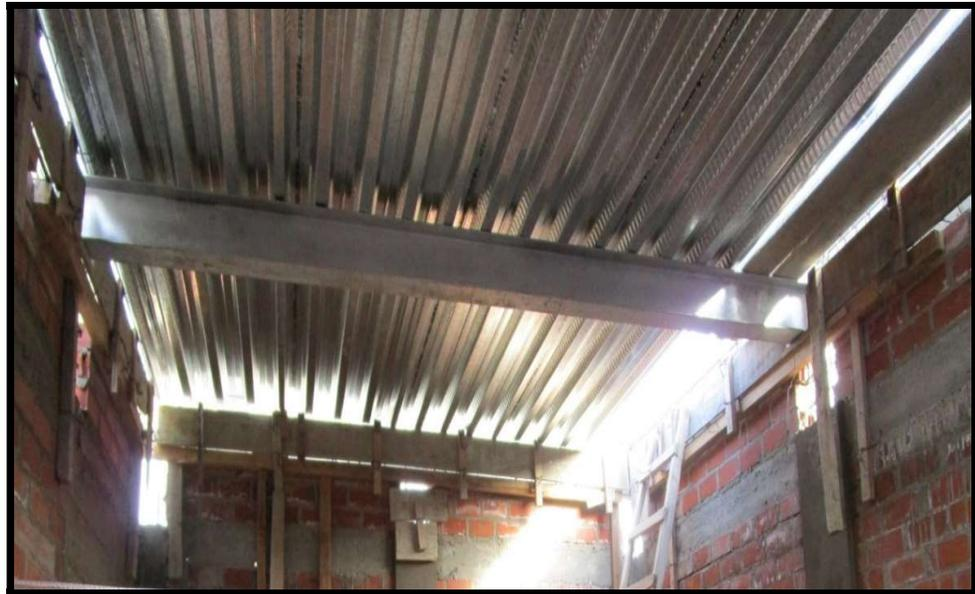
**Foto 22:** Instalación de viga H y placa deck en sala de equipo
