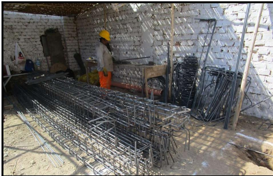
**Foto 14:** Habilitación de acero para columnas de sala de equipos
