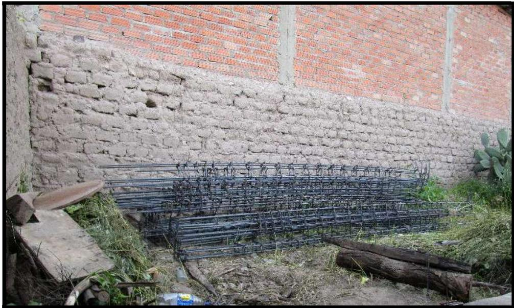
**Foto 2:** Habilitación de acero para columnas de sala de equipos
