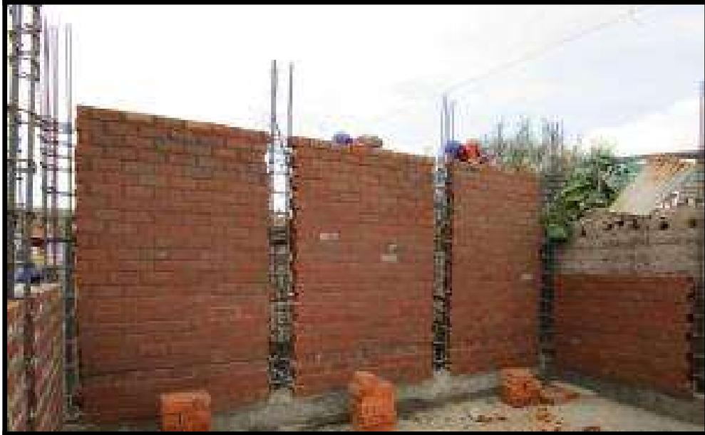
**Foto 5:** Asentado de ladrillo en sala de equipos
