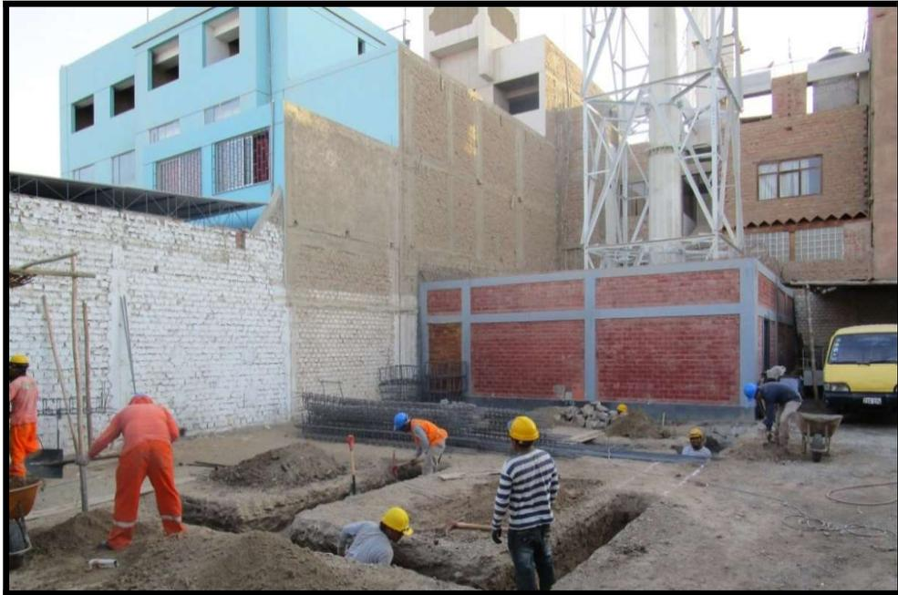
**Foto 13:** Excavación de cerco perimétrico
