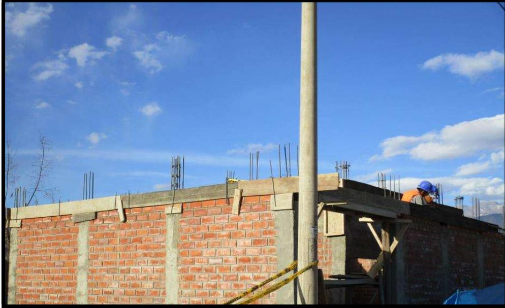
**Foto 11:** Vaciado de viga collarín en cerco perimétrico
