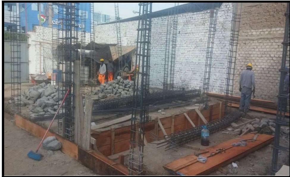
**Foto 16:** Vaciado de sobre cimentación en sala de generadores
