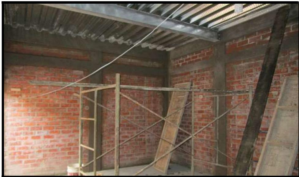
**Foto 10:** Instalación de viga H y placa deck en sala de equipo
