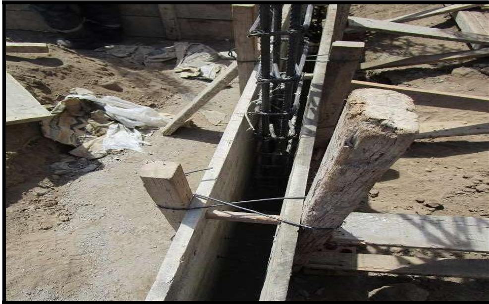
**Foto 15:** Vaciado de sobrecimiento en cerco perimétrico
