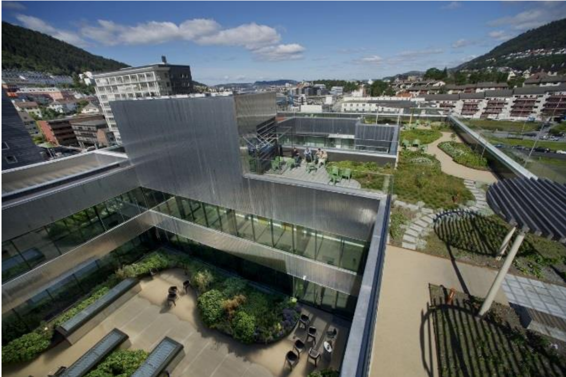
Figura N° 14, vista espacialidad, hospital psiquiátrico Kronstad Recuperado de http://www.archdaily.pe/pe/02-313387/hospital-psiquiatrico-kronstad-origo-arkitektgruppe/528ebcdce8e44efc1f000201-kronstad-origo-arkitektgruppe-photo
