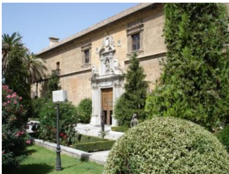
Figura N° 3, fachada Hospital Real Granada
