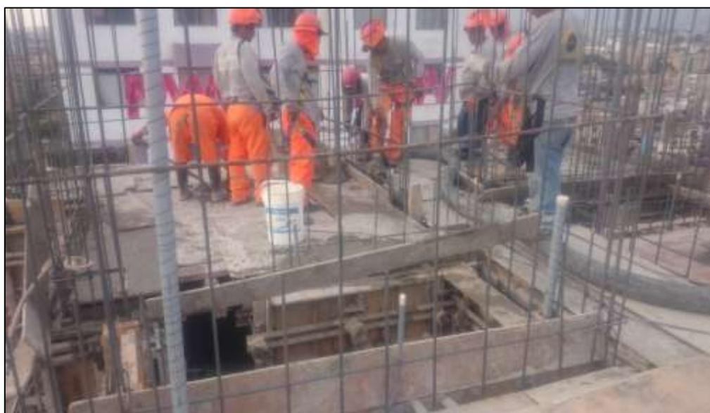
**Figura 11.** Vaciado de concreto en placa
