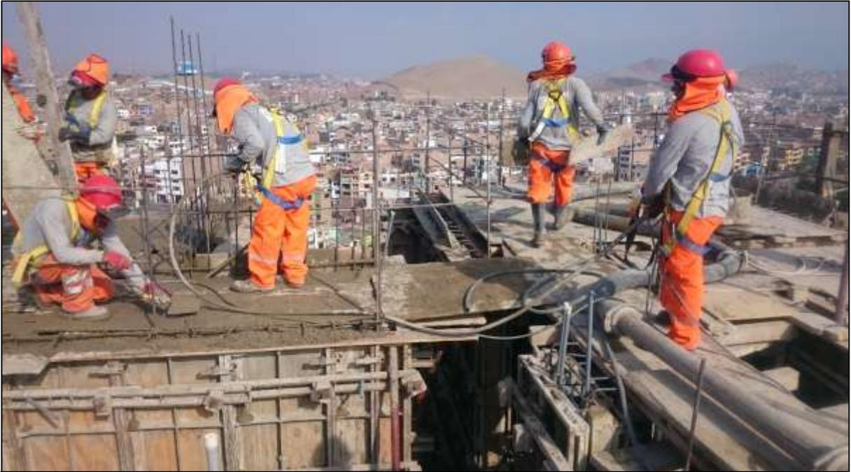
**Foto 6:** Vaciado de muros Piso 14 – Sector 4
