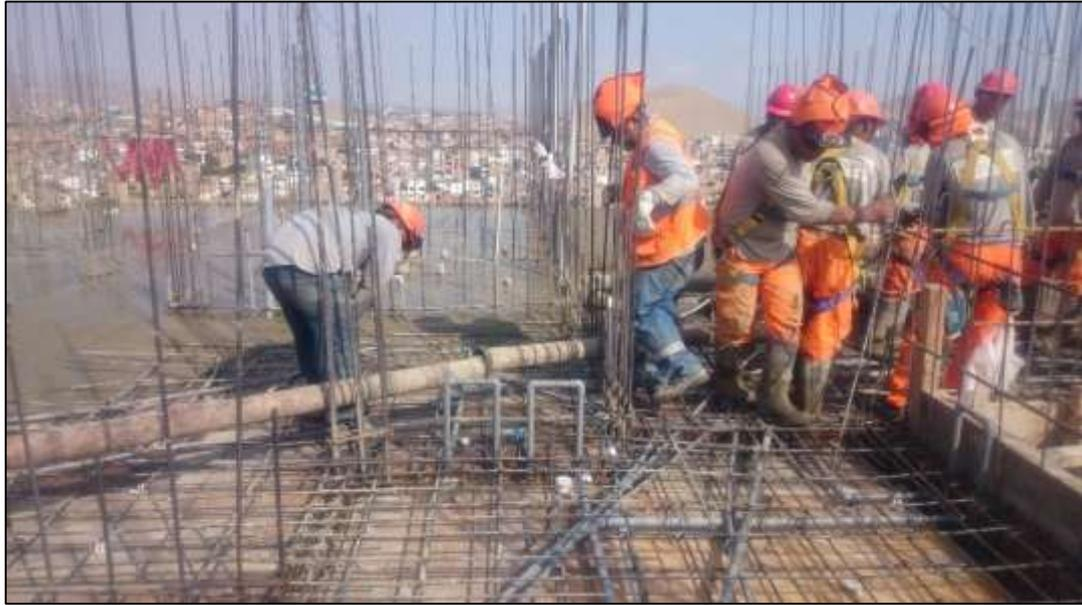
**Figura 15.** Vaciado de concreto en losa
