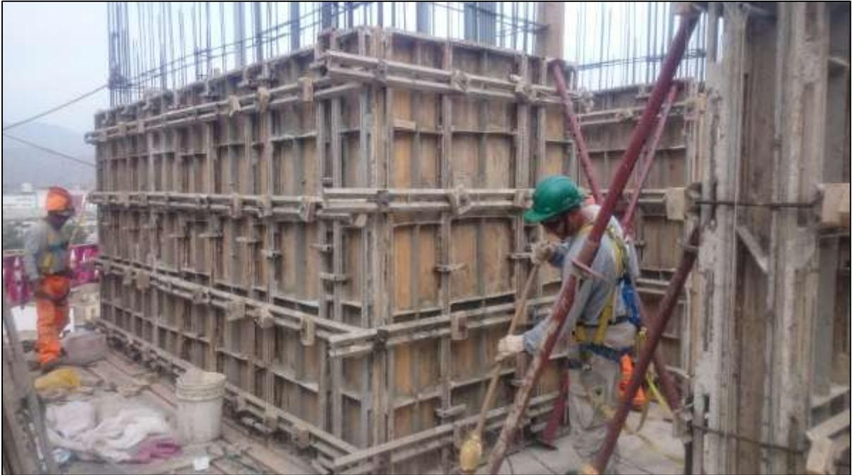
**Figura 7.** Encofrado metálico con fenólico
