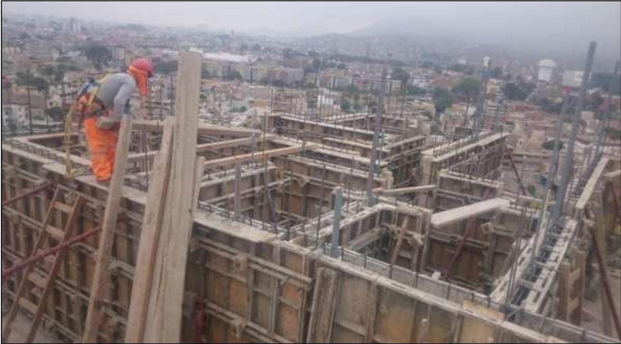
**Foto 5:** Encofrado de muros Piso 14 – Sector 2
