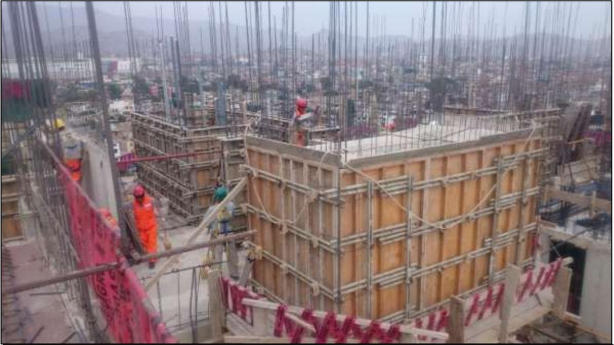
**Foto 3:** Encofrado de muros Piso 14 – Sector 3
