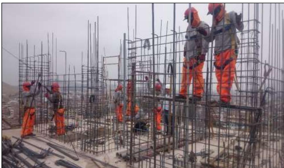
**Figura 19.** Colocación de acero en placas
