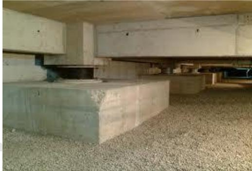
**Figura 10:** Aisladores sísmicos, Seismic Protection Technologies
