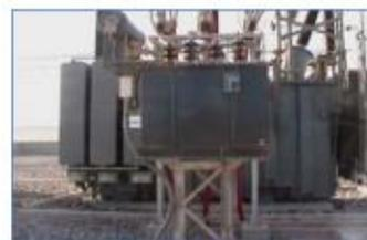
Transformador de 35 MVA – 220 kV
