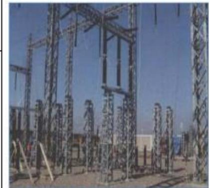
Vista de montaje de polos de seccionador triéscara 220 kV
