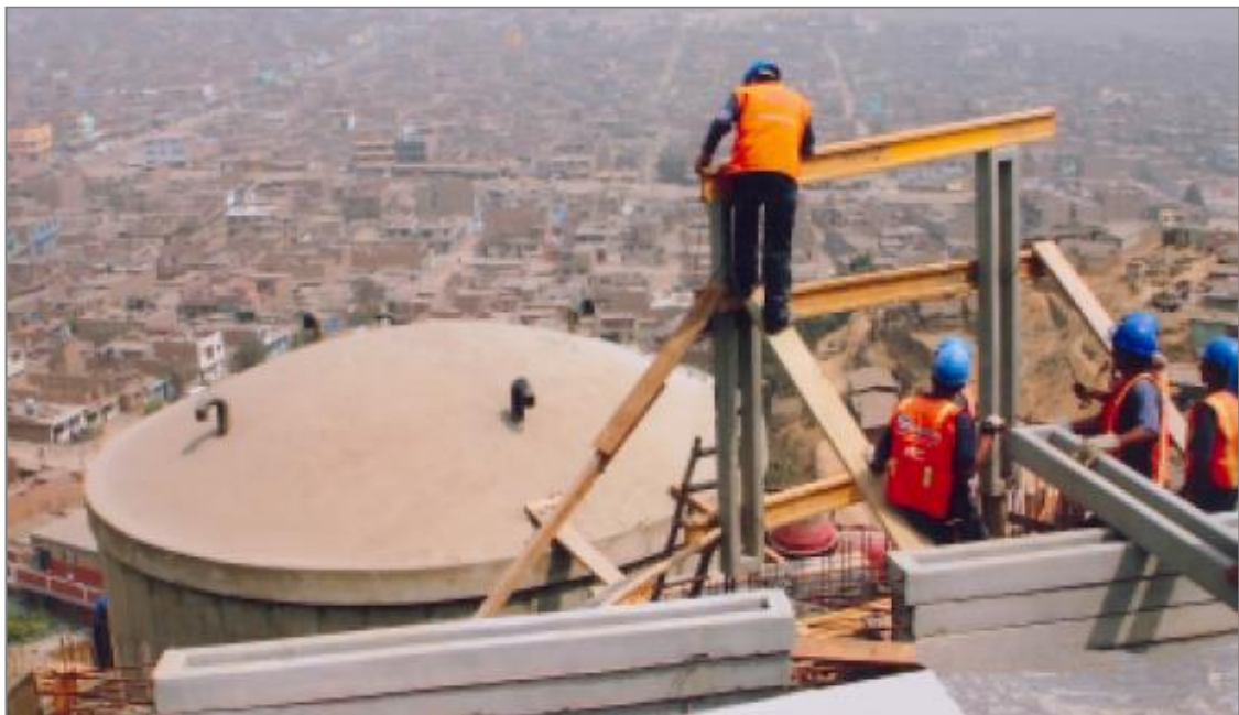
Fotografía 2.1: Vista de la construcción de 14 reservorios de almacenamiento de agua potable en las zonas altas de Huaycán.
