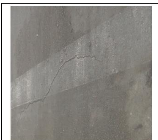
Fisura transversal
