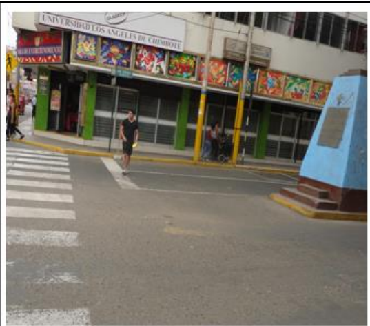
Desprendimiento de agregados
