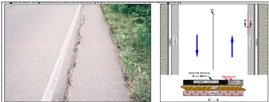
Figura 28: Desnivel Carril Berma. (DN, unidad de medida: m)
