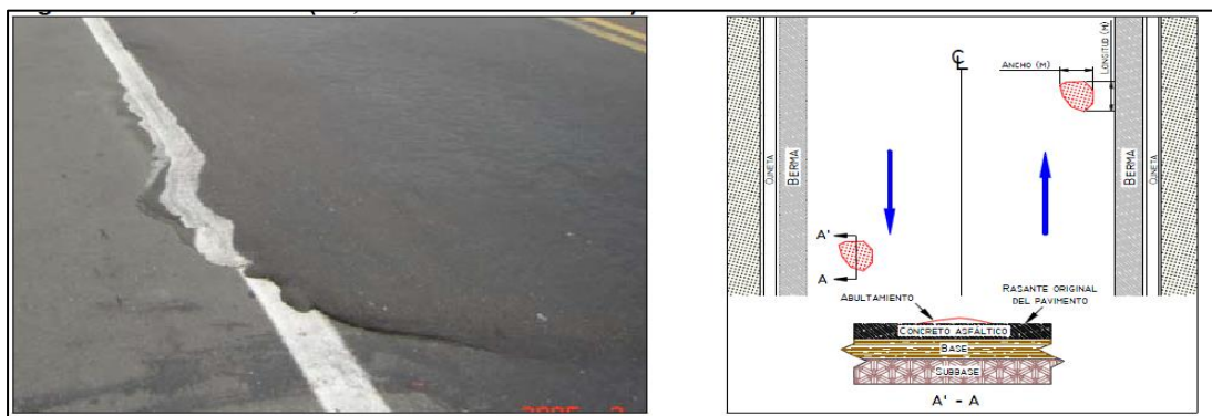
Figura 17: Abultamientos. (AB, unidad de medida: m 2 )
