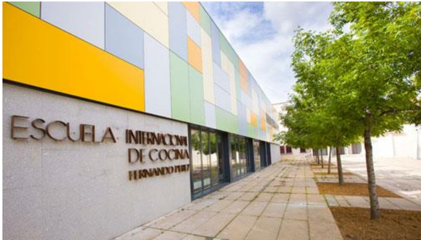
Figura7: Fachada principal de la Escuela / Fuente: http://www.actiu.com/es/proyectos/europa/escuela-internacional-de-cocina-fernando-perez
