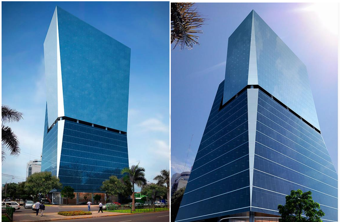
Gráfico 16. Vista 3D, Edificio para Oficinas JP Fuente: Manual de Calidad del Proyecto Edificio JP
