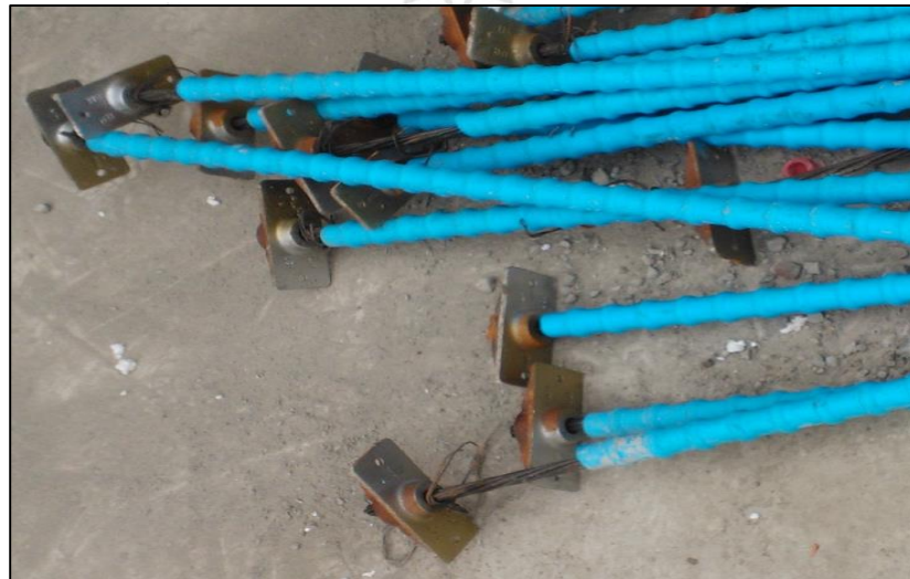
Gráfico 7. Anclajes donde se transmiten las fuerzas de tensión
