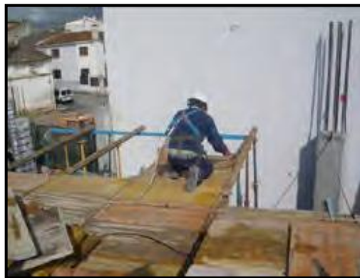
Ilustración 5: Montaje de entablado de losa con utilización de arnés de seguridad.
