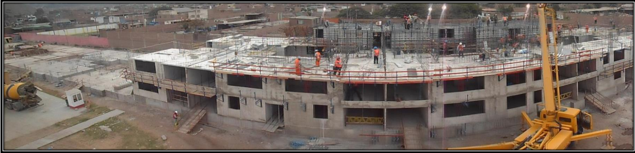
VISTA PANORAMICA TORRE "L - M" (18 FEB)
