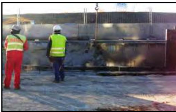
Ilustración 2: Desmontaje de paneles de encofrado.
