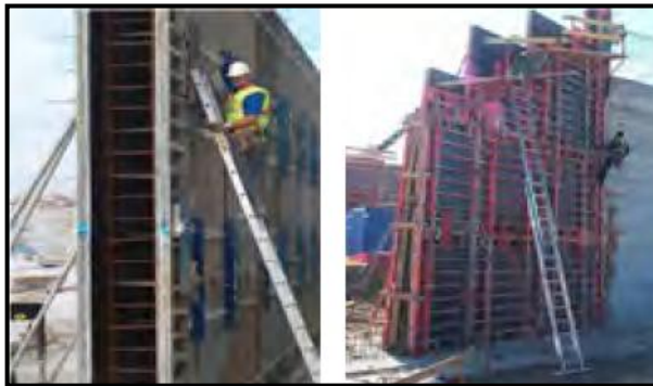
Ilustración 3: Trabajo de montaje de elementos auxiliares en encofrado vertical.
