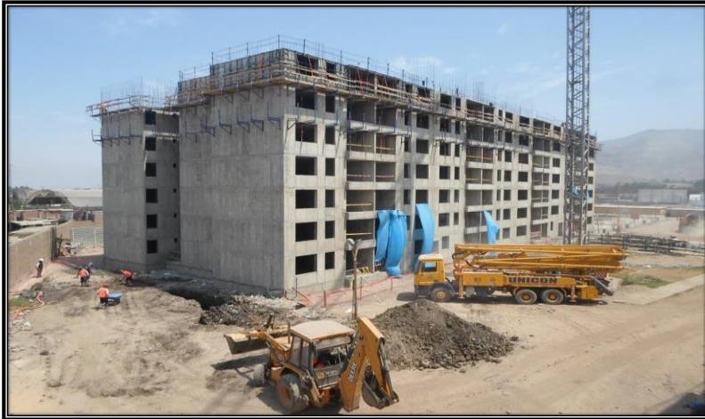
VISTA (TORRE J - K) (08-ABR)
