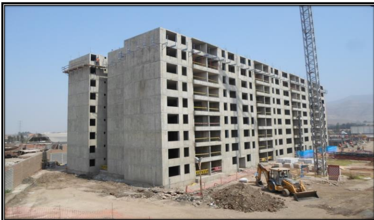
VISTA (TORRE J - K) (22-ABR)
