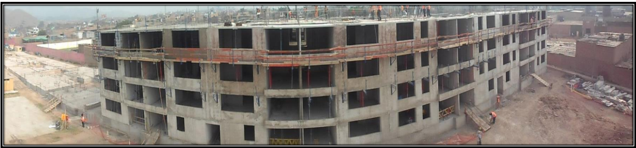
VISTA PANORAMICA TORRE "L - M" (26 FEB)
