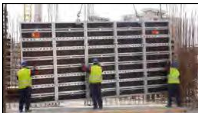
Ilustración 1: Eslingaje, movimiento y posicionamiento de encofrados
