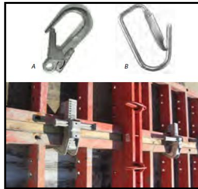
Ilustración 4: Ganchos para arnés de seguridad. Grapas en la unión de paneles.
