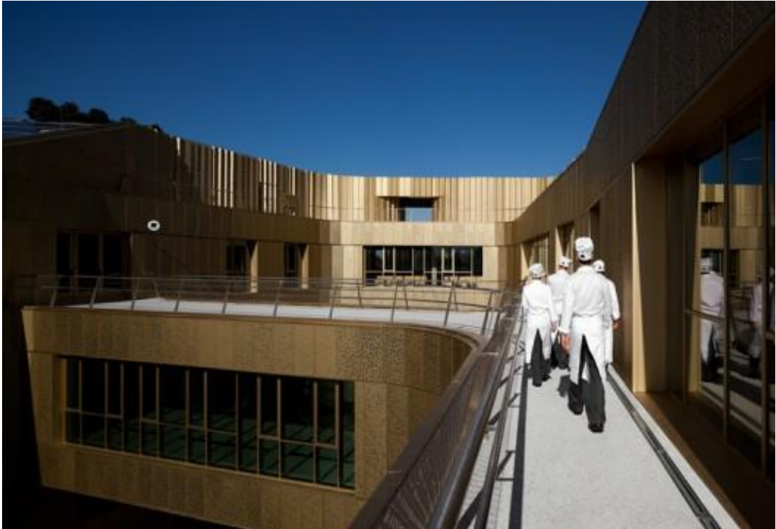
Figura N° 02: Pasillos abiertos en la cubierta superior Fuente: Internet
