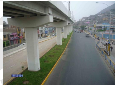
Figura N°27: Central de la línea 1 del tren eléctrico.
