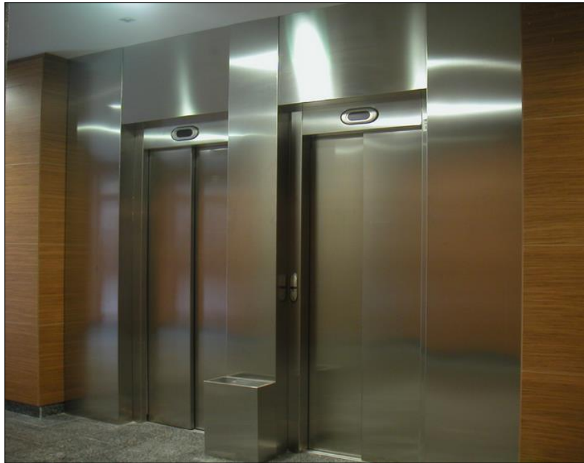
Figura N° 35: fotografía de ascensor
