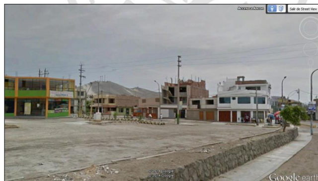
Figura Nº 5: fotografía de una mala integración del espacio urbano
