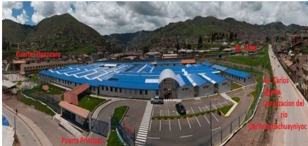
Figura 1. Vista panorámica del Hospital.
