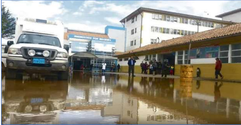
Figura 4. Área de emergencia y mantenimiento en el Hospital Regional.
