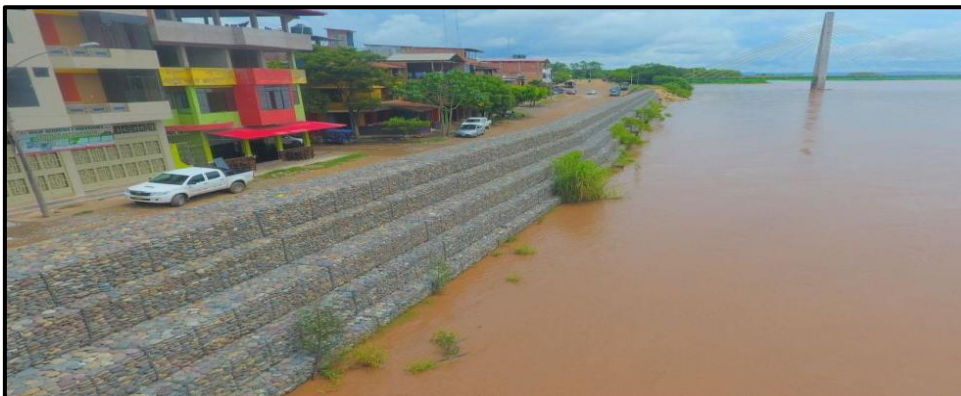
Muro de gaviones
