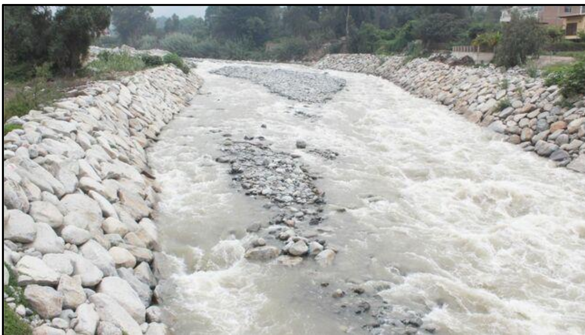
Muro enrocado
