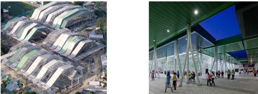
Nota La Imagen de la izquierda es de la Cubierta en Construcción y la Imagen de la derecha es la Imagen de las columnas en forma de arboles
