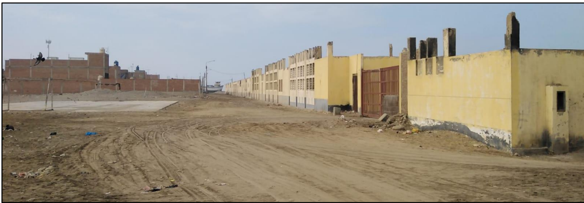
Figura 62: Vista desde la Av. Tupac Amaru. Fuente: Propia
