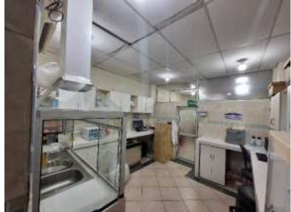
Cielo raso del laboratorio clínico
