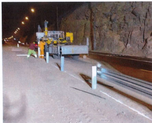
Instalación de Barandas Metálicas
