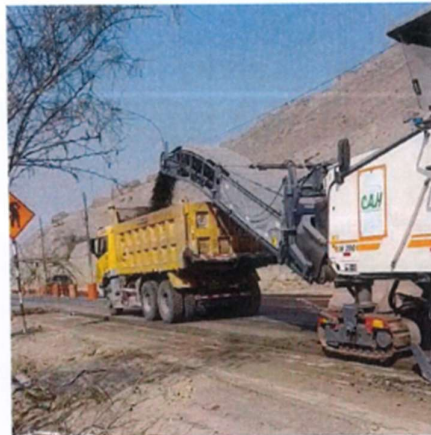
Demolición de carril provisional
