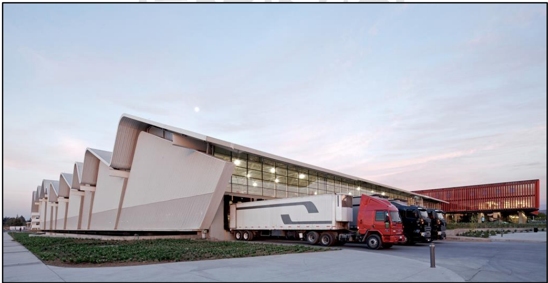
Figura N° 09: Vista desde el patio de maniobras de carga y descarga Fuente: archdaily.pe
