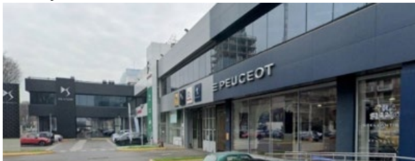
Figura 35 Edificios de estacionamiento
