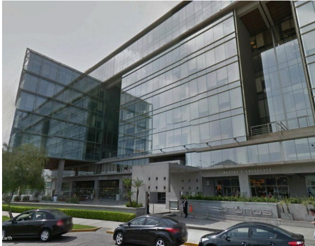
Figura 24 Fachada de edificio
