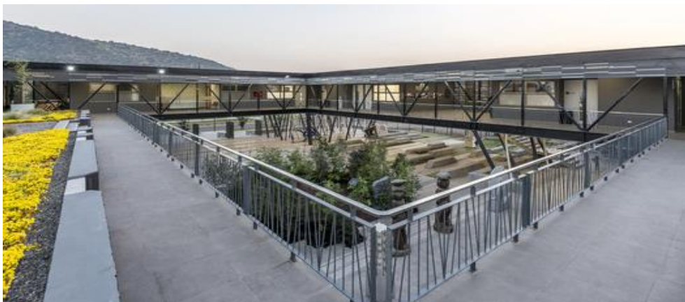
Figura 18. Fotografía que muestra las plazas del proyecto
