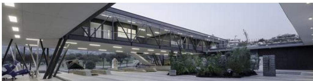
Figura 16. Fotografía donde muestra los bloques suspendidos
