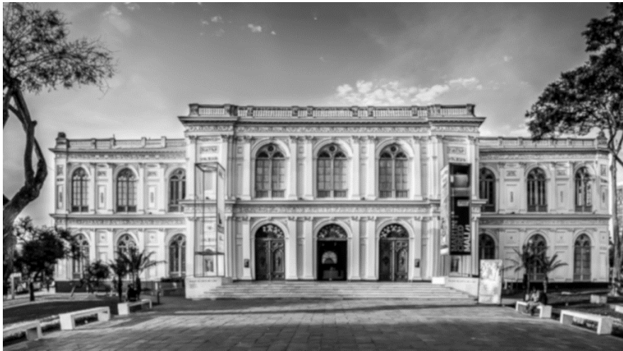
Figura 2. Fotografías que muestran sus muros de fachada.
