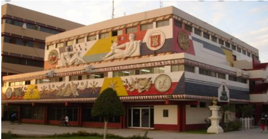
Figura 22. Fotografía de la Biblioteca Municipal
