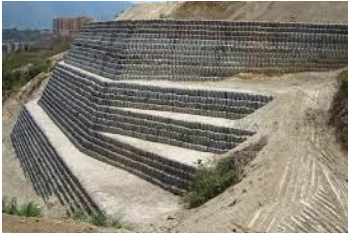
Figura 25. Defensas ribereñas con terraplenes
