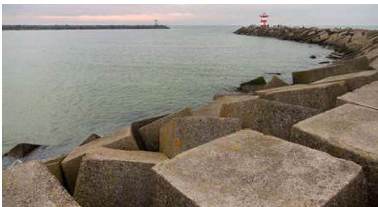
Figura 24. Escolleras o rompeolas como defensas
