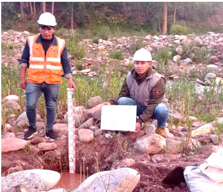
Fuente: El autor. (2023). Calicata 01
