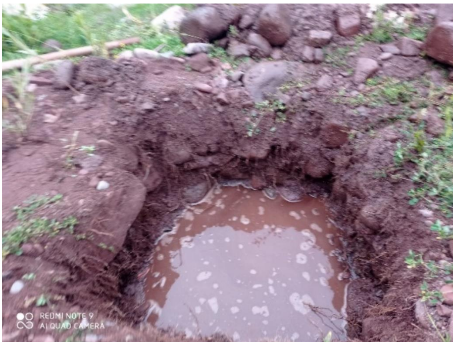
Fuente: El autor. (2023). Calicata 02
