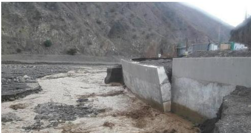
Figura 22. Muros de concreto armado (Huarmaca), en Piura
