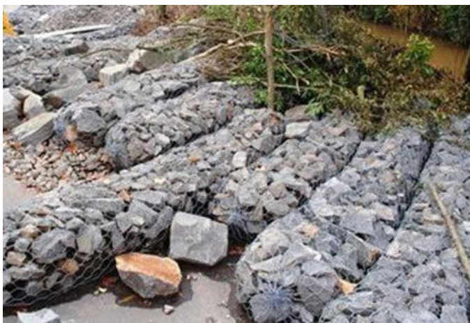
Figura 34. Saco de gaviones de alambre de acero que teje
