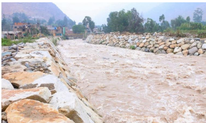
Figura 23. Defensa ribereña enrocados río Santa Eulalia y Rímac
