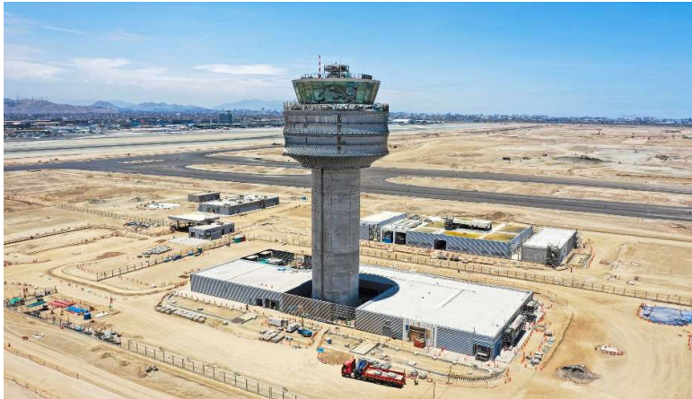
Figura 33 Nueva torre de control
