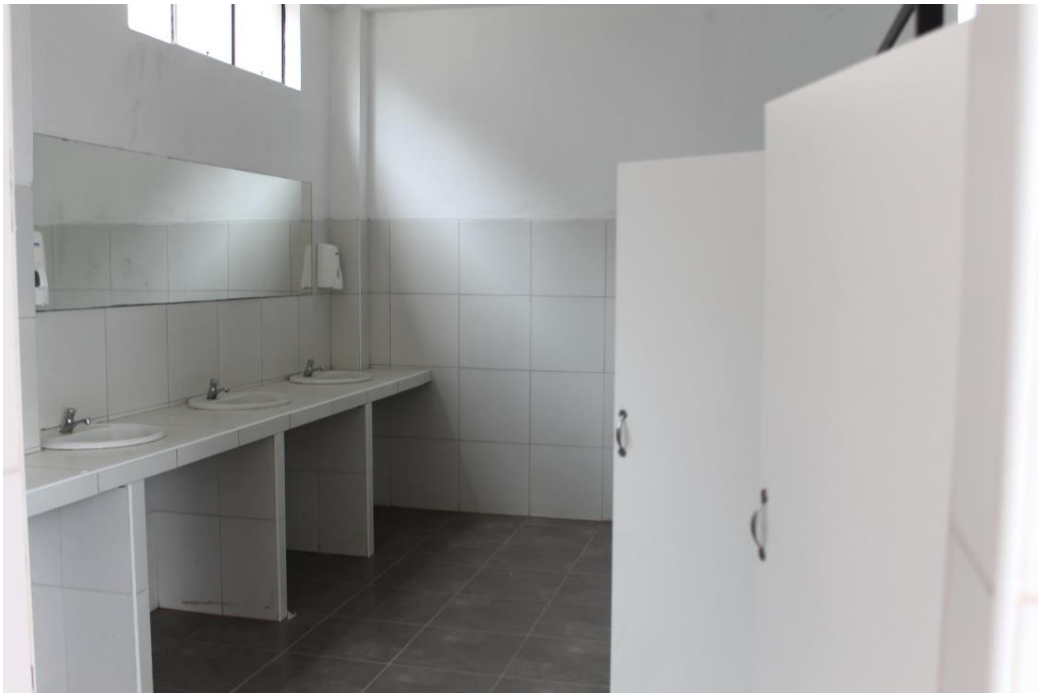
Figura 4.7: Servicios Higiénicos Fuente: Fotografía Propia
