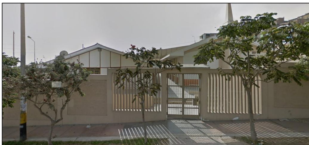
Fuente: Google LLC _ Google Earth, 2021
