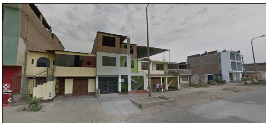
Fuente: Google LLC _ Google Earth, 2021
