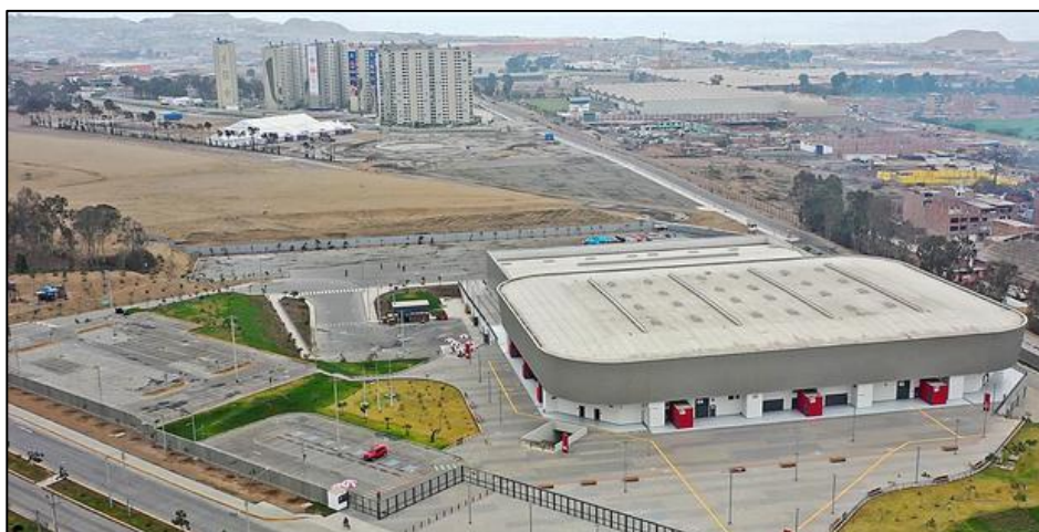
Fuente: Google LLC _ Google Earth, 2021
