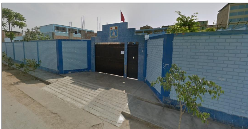
Fuente: Google LLC _ Google Earth, 2021
