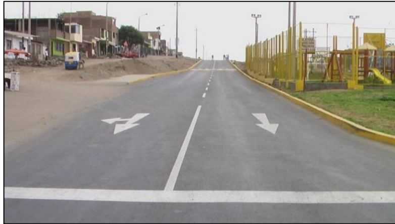
Fuente: Google LLC _ Google Earth, 2021
