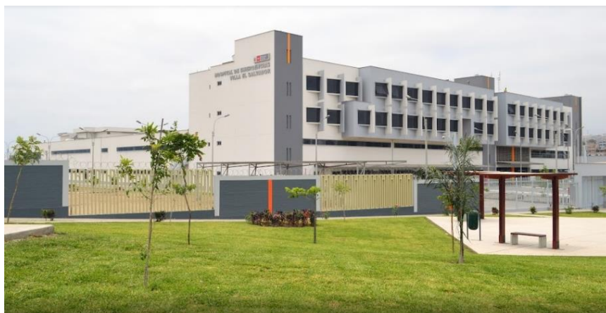
Fuente: Google LLC _ Google Earth, 2021
