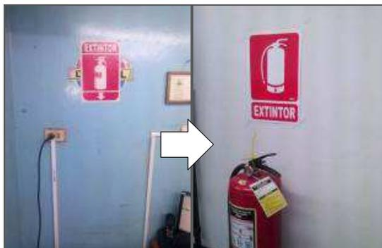
**Figura N°96.** Señalización del extintor
