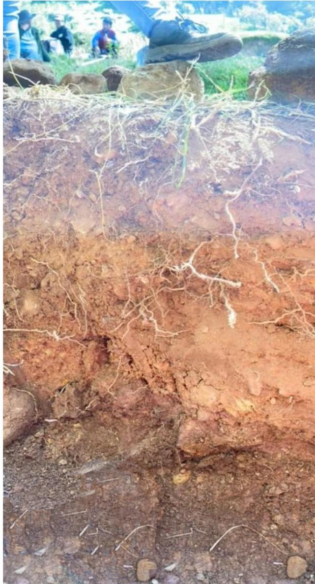
Nota. La figura muestra los componentes de la estructura de la trocha AP-557 en Chumbibamba, los cuales son: subrasante, subbase, base y carpeta de rodadura. Fuente: Los autores (2022)
