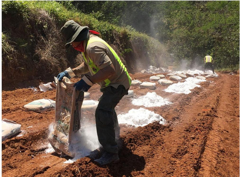
Nota. La siguiente figura muestra una forma de incorporar cal al suelo para estabilizarlo. Fuente: Horcalsa (2020).
