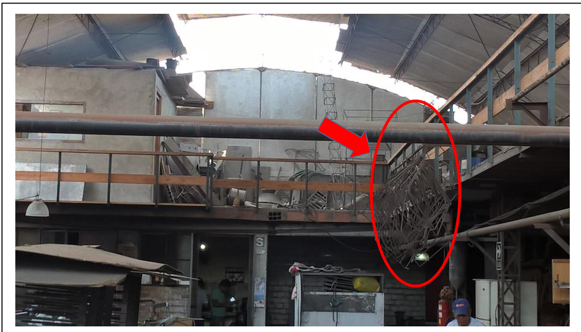
Imagen 4: Alambres colgados en las barandas
