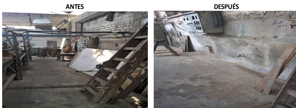
Figura 54: Limpieza y retiro de escaleras en zona eléctrica
