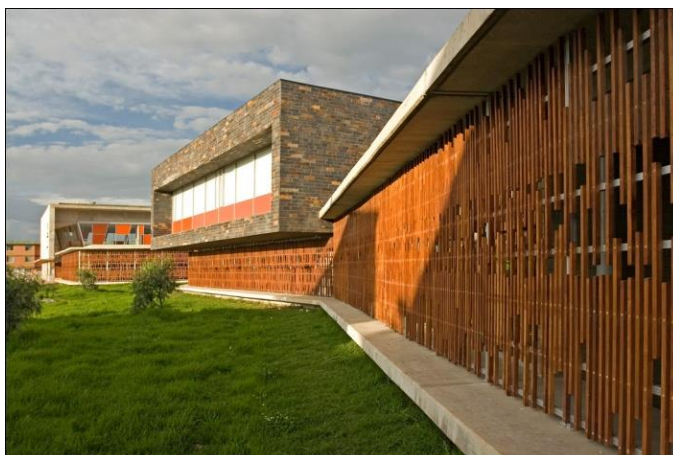
Img. 25 Vista exterior - Fuente: http://www.plataformaarquitectura.cl
