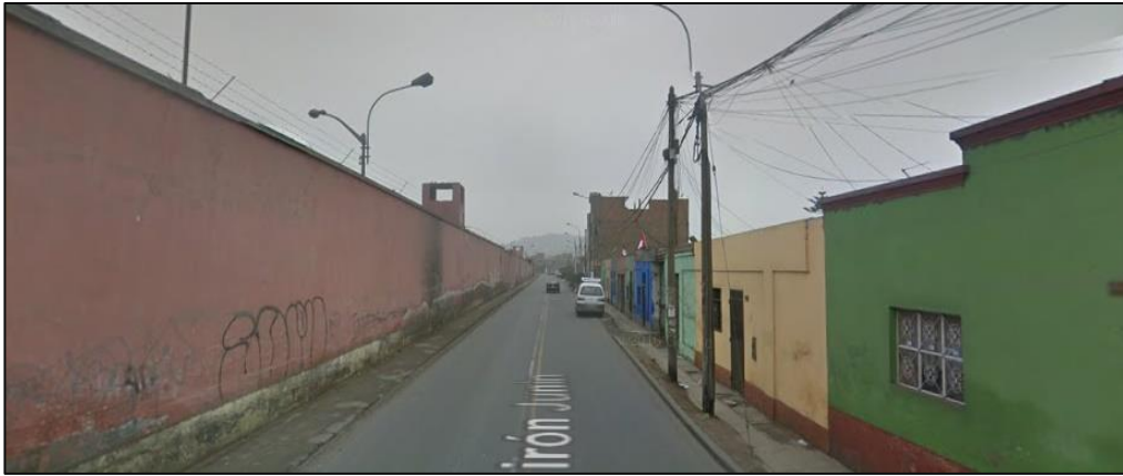
Figura 29. Vista frente del sur – Jr. Junín
